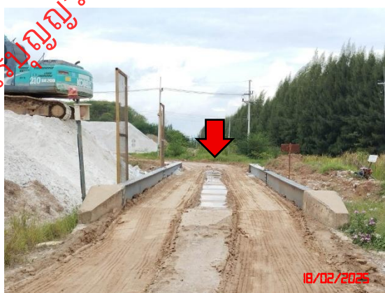
รูปที่ 7 จุดซังน้ำหน้ารถบรรทุกทุกขนส่งแร่
